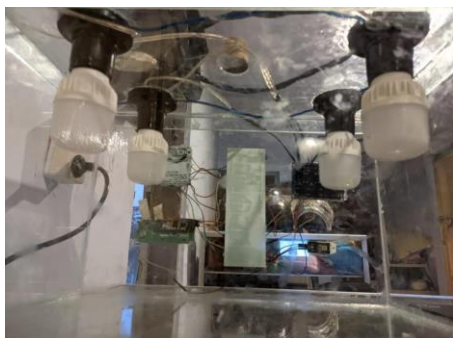
Gambar 4.2 Hasil Instalasi Lampu
